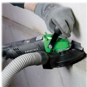
Arbeiten an engen Stellen
