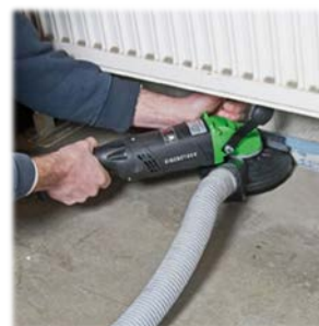
Arbeiten an engen Stellen
