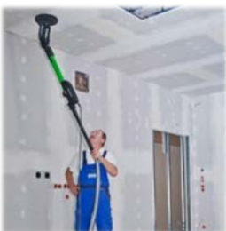
VacuGlide-System – entspanntes Schleifen von Decken...
