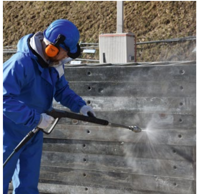
Reinigung von Schalungen
