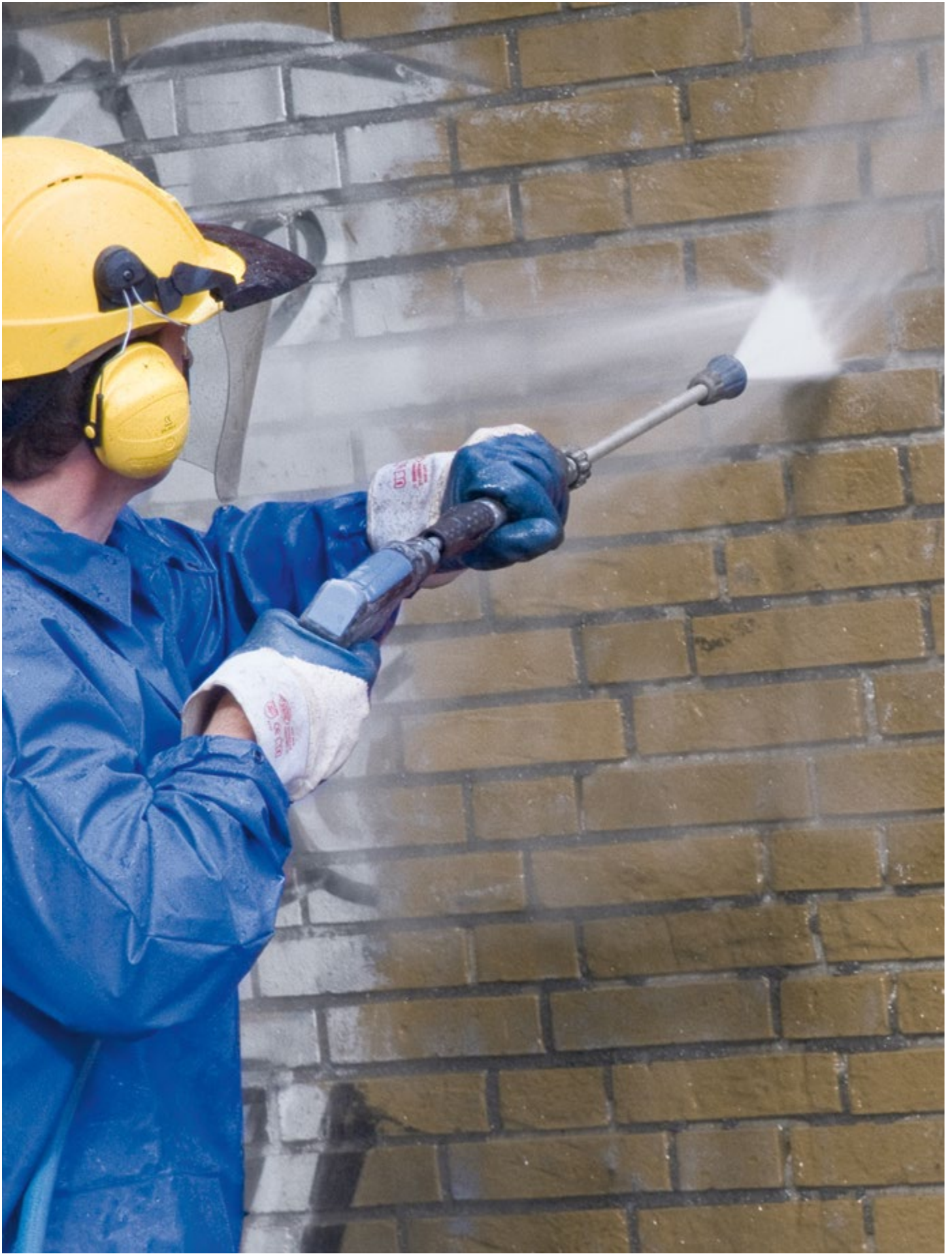
Entfernung von Graffiti
