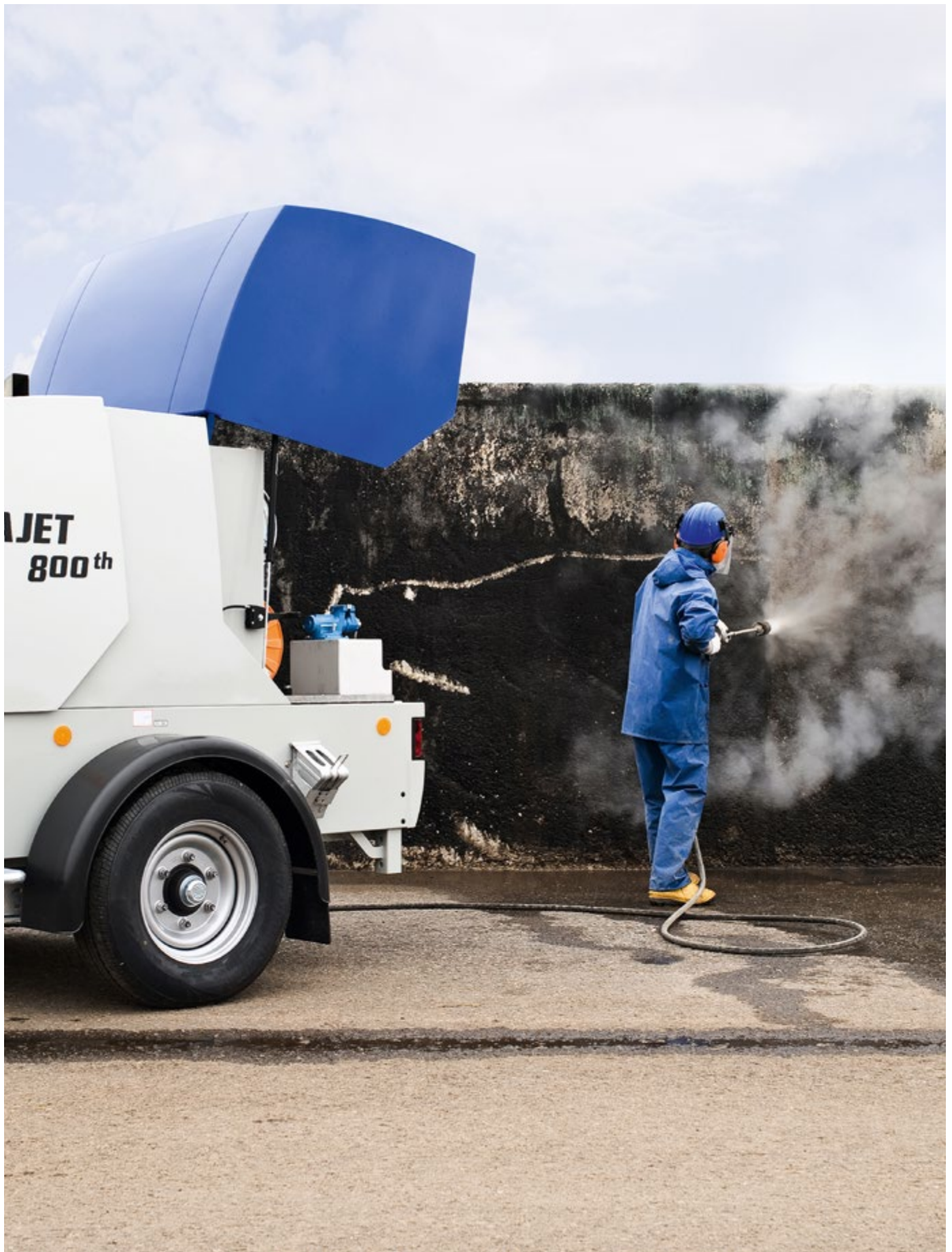
Sanierung eines Fahrsilos
