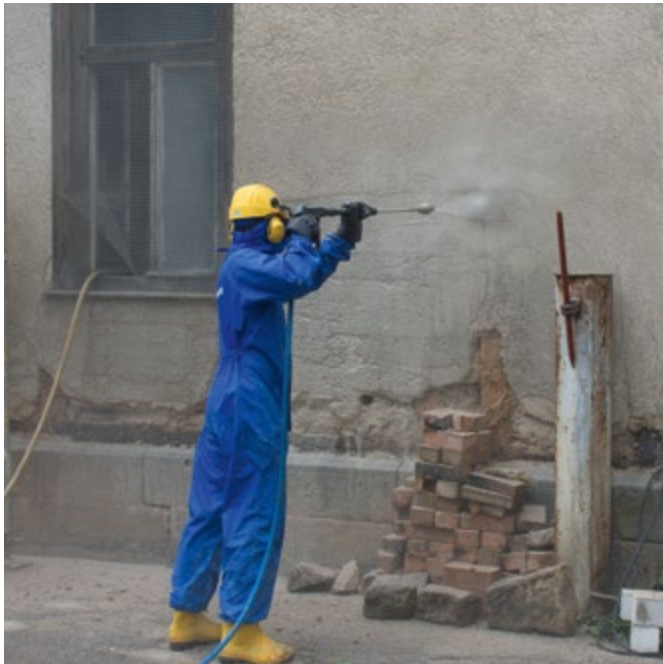
Sanierung einer Fassade
