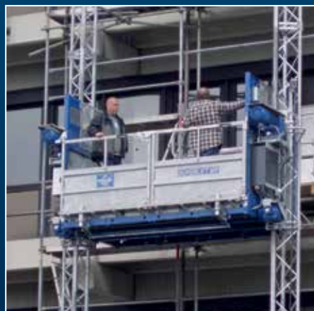
MX 2024 – B30 parallel zur Fassade
