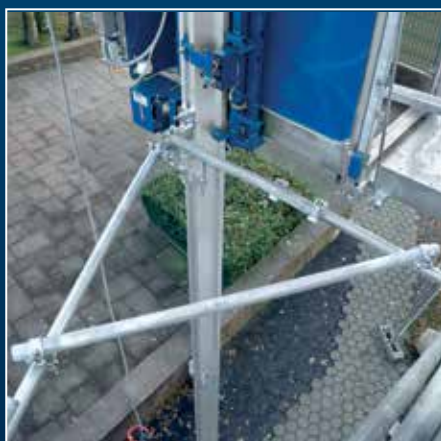
Wahlweise Gerüst- oder Wandverankerung
