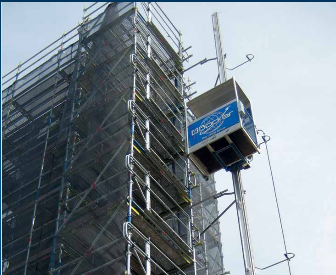
Der Superlift MX 324 ist die kompakteste Transportbühne für beengte Baustellen
