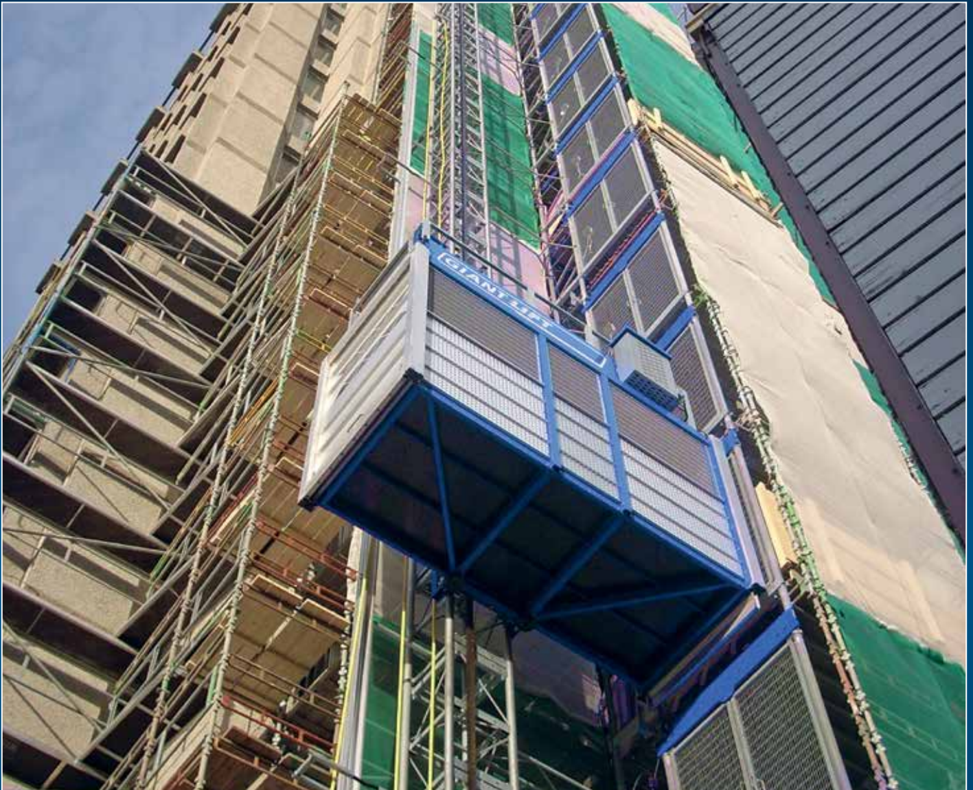
Einsatz am Haltestel GIANT-Lift Einsatz mit Haltestellengerüst
