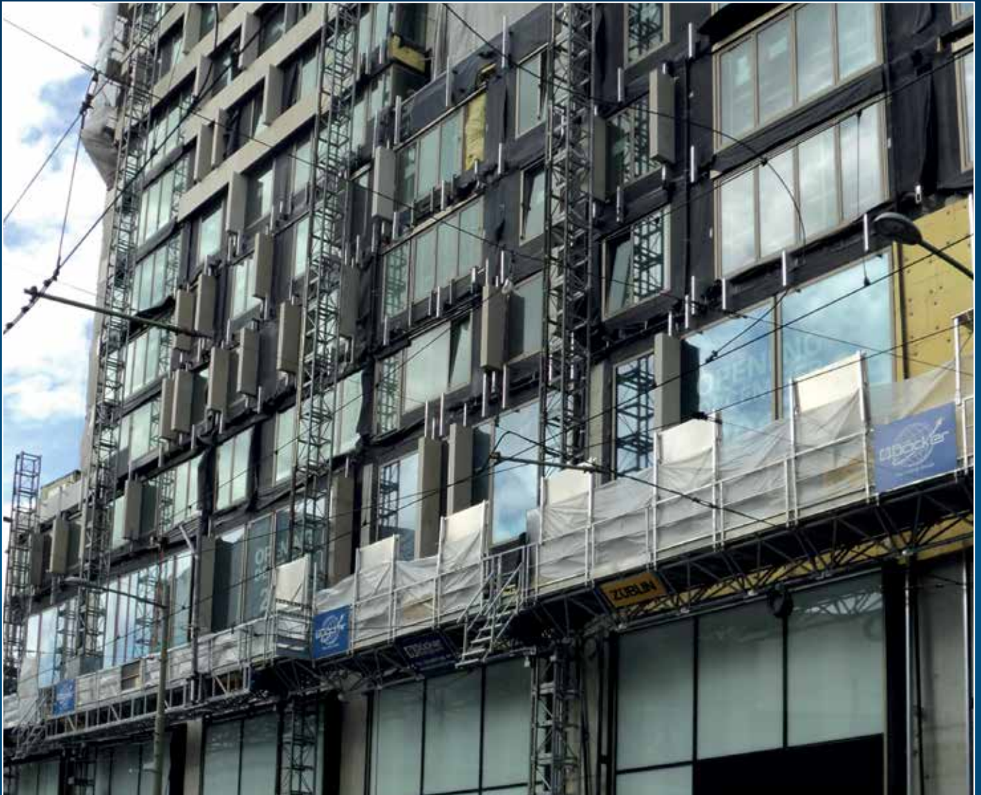
Modularer Aufbau des Maxi-Climbers
