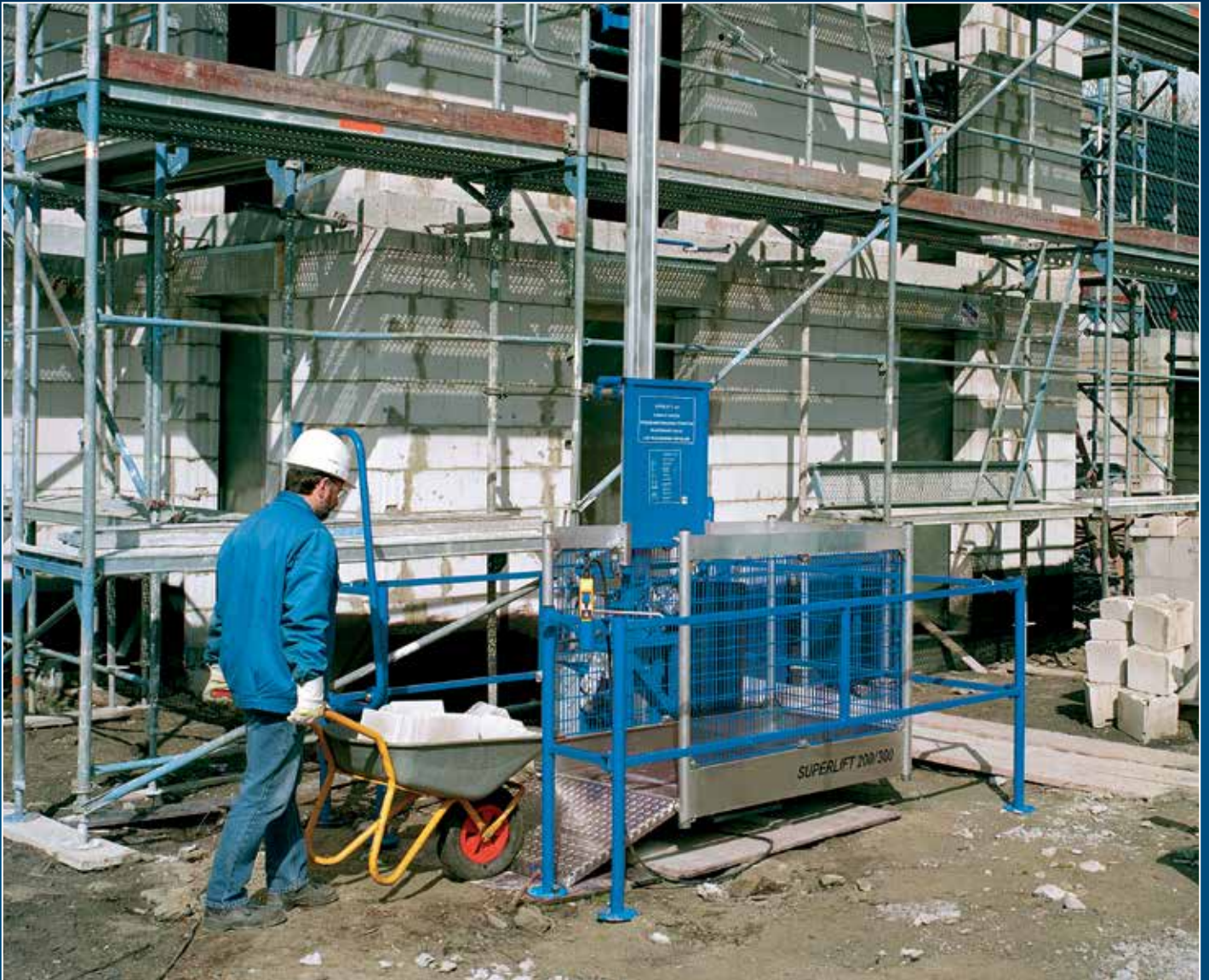
Große Lastbühne des Superlift Z 320 / Z 330 gewährleistet eine einfache Beladung
