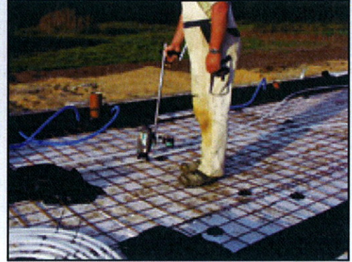
Befestigung von Rohren für die Fußbodenheizung (Verlängerungsarm als Zubehör erhältlich)
