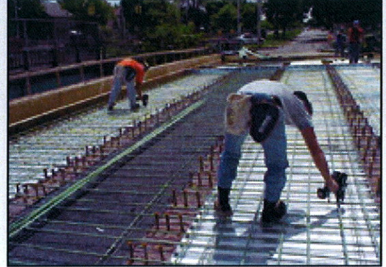
Brückenkonstruktionen, Decken, usw.
