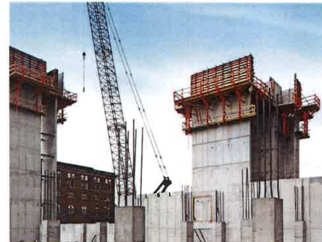
Das Klettergerüst KLK 230 besteht aus Kletterkonsolen, Wandstützen, Belag und Geländer.
