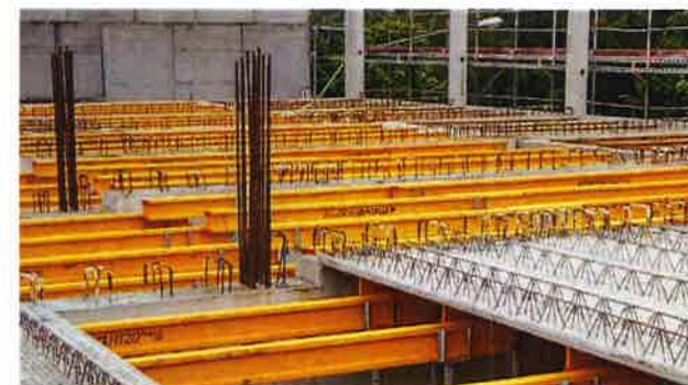
MevaFlex eignet sich ideal als Unterstützung für Fertigteil-Decken.
