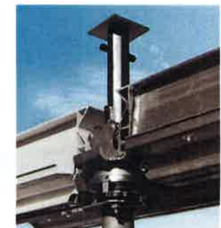
Fallkopf mit um 19 cm abgesenkten Hauptträgern.
