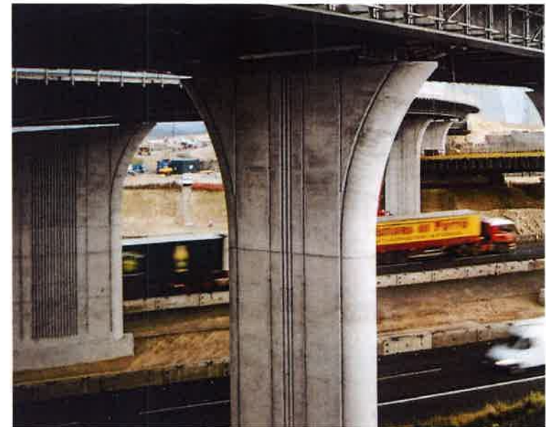
Auf Basis der Rundsäulenschalung Circo kann eine Sonderschalung für geneigte und gebogene Bauteile gefertigt werden. Hier am Beispiel Holmfield Exchange, UK.
