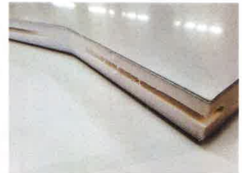
Eingefräst und stumpf gestoßen, mit Lamello-Verbindern und ohne Schweißnaht verbunden.
