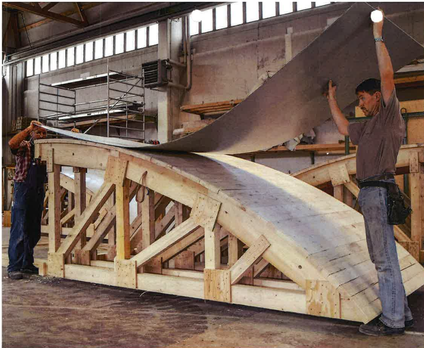
Großflächige alkus Vollkunststoff-Platte 6 mm (GM) auf einer Holzunterkonstruktion.
