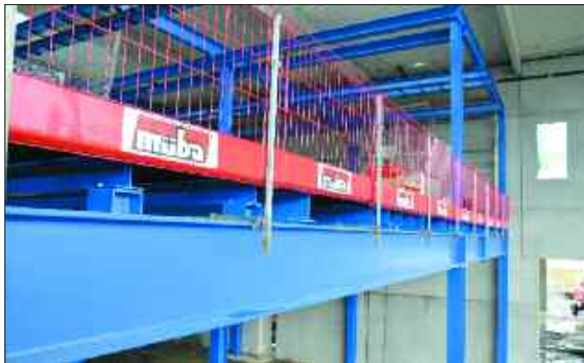
AS- System im Einsatz mit T-Trägerklemmen
