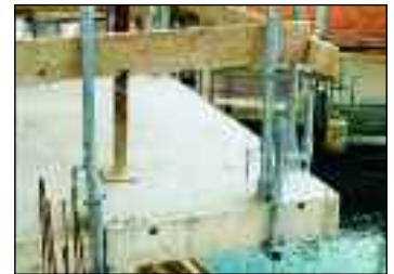
Schutzgeländerzwingen an Betondecke ange- schlagen.
