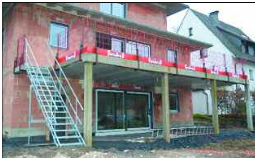
AS- System im Einsatz mit T-Trägerklemmen
