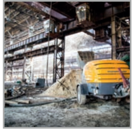
Russland, Ryazan ~ 100 000 m 2 Estrich verlegt
