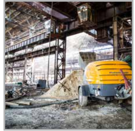
Russland, Ryazan ~ 100 000 m 2 Estrich verlegt
